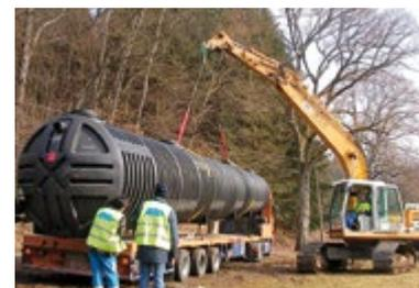
▲ Appareils DP manutentionnés et posés par la pelle ayant réalisé l'excavation.
