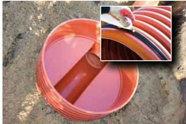
Zum Aufziehen der beigelegten Dichtung (Schachtboden/Steigrohr) zunächst das unterste Wellental des Steigrohres von Verunreinigungen befreien und mit Gleitmittel einstreichen. Die passende Dichtung in die dafür vorgesehene Welle einlegen. Den Steckbereich des Schachtbodens einstreichen und das Steigrohr bis zum Anschlag zusammen schieben.
