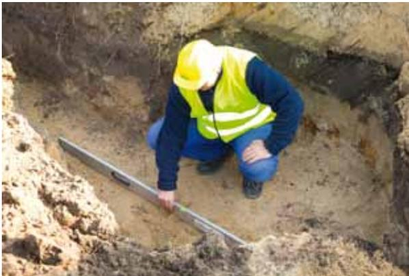
Der Auflagebereich des Schachtbodens hat gemäß DIN EN 1610 zu erfolgen. Der Untergrund muss tragfähig und eben sein. Dazu eine mindestens 10 cm dicke Bettungsschicht (Sauberkeitsschicht) erstellen.
