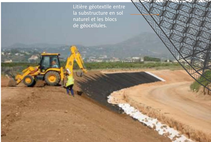
Litière géotextile entre la substructure en sol naturel et les blocs de géocellules.
