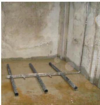
L'aération fine bulles est réalisée par la mise en place en fond de bassin d'un ensemble de rampes de distribution en inox débouchant sur des membranes tubulaires d'aération en EPDM.
